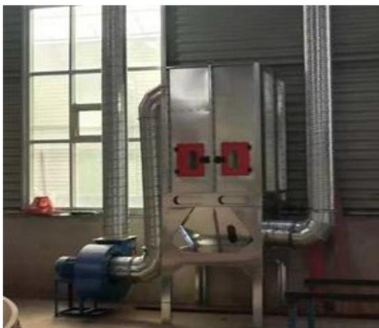
图4-3裁切工序布袋除尘器（东）
