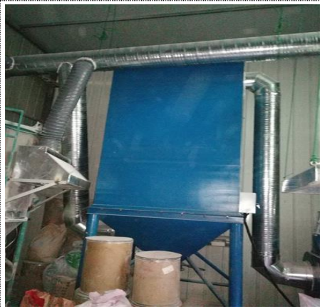
图 4-3 脉冲布袋除尘器设备
