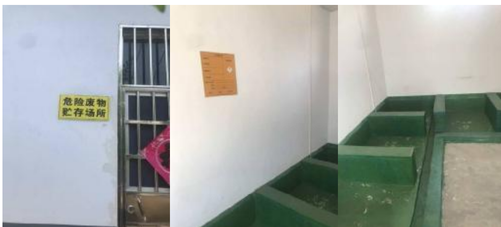
图4-5 危险废物暂存场所
