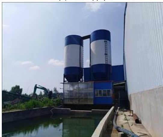
图 3-6 泥浆罐+压滤机+沉淀池
