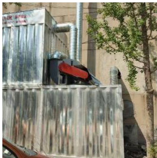
图 4-2 脉冲布袋除尘器
