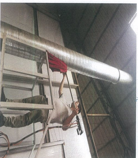
图 1 包覆工序废气出口现场采样
