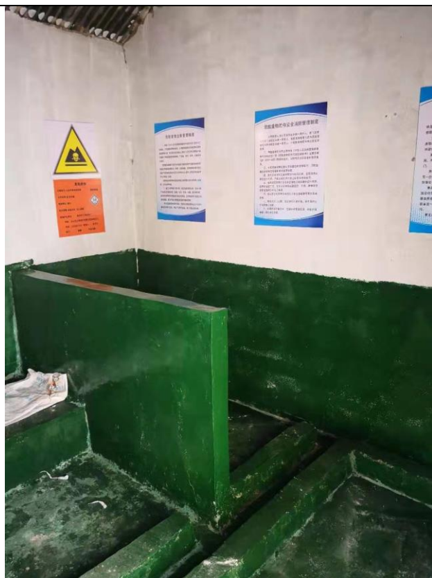
危险废物暂存处
