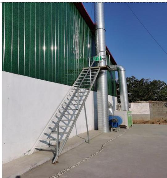
图 4-3 排气筒采样平台
