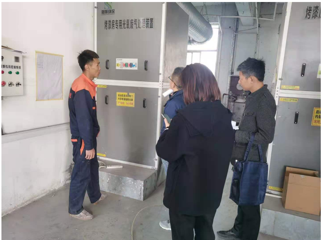
验收工作组踏勘项目现场
