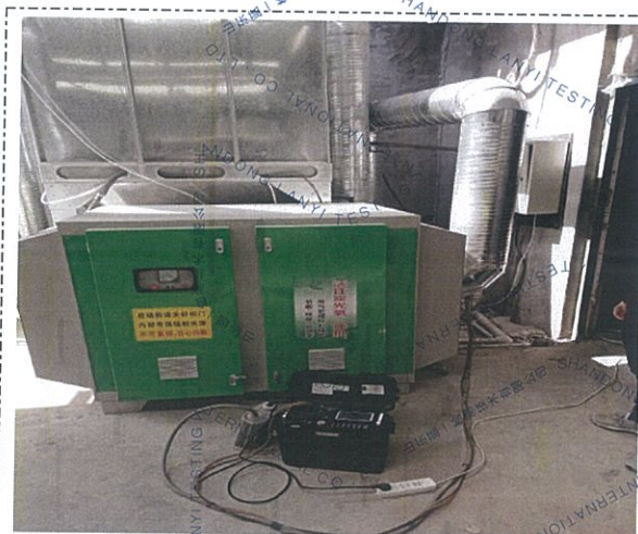
图 1: 投料、混料、挤出废气出口现场采样图
