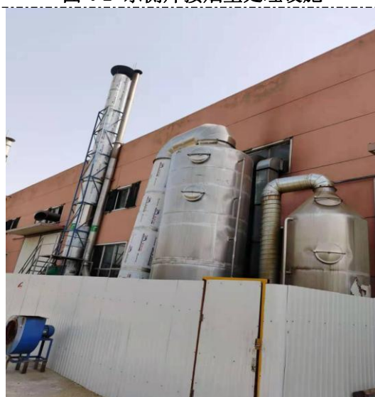
图 4-4 喷漆废气、烘干分期处理系统
