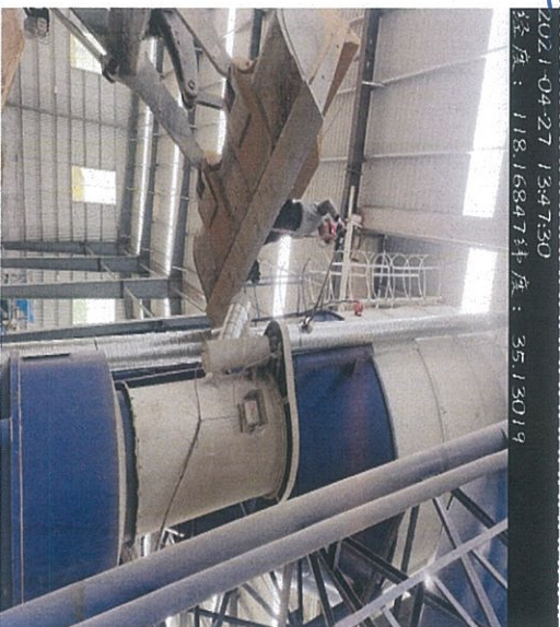
图 3: 公路材料筒仓放空除尘器出口现场采样图
