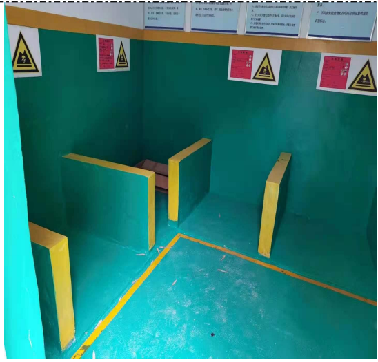
图 4-6 危废库内部分区及防渗
