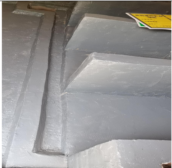
危废库内部防渗
