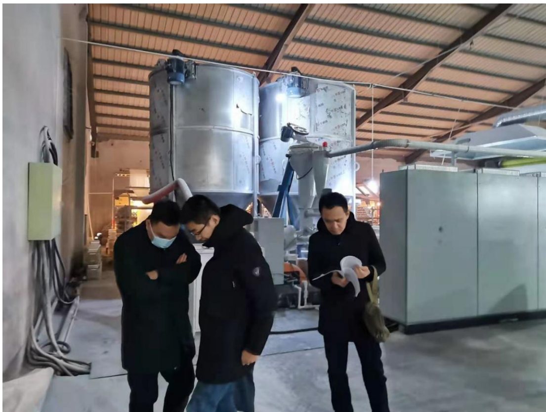
验收工作组踏勘项目现场
