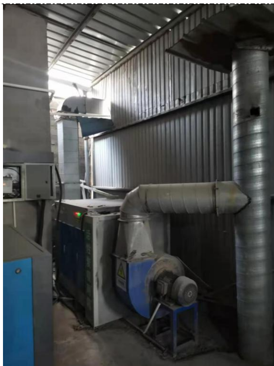
图 4-1 融化拉丝废气处理设施
