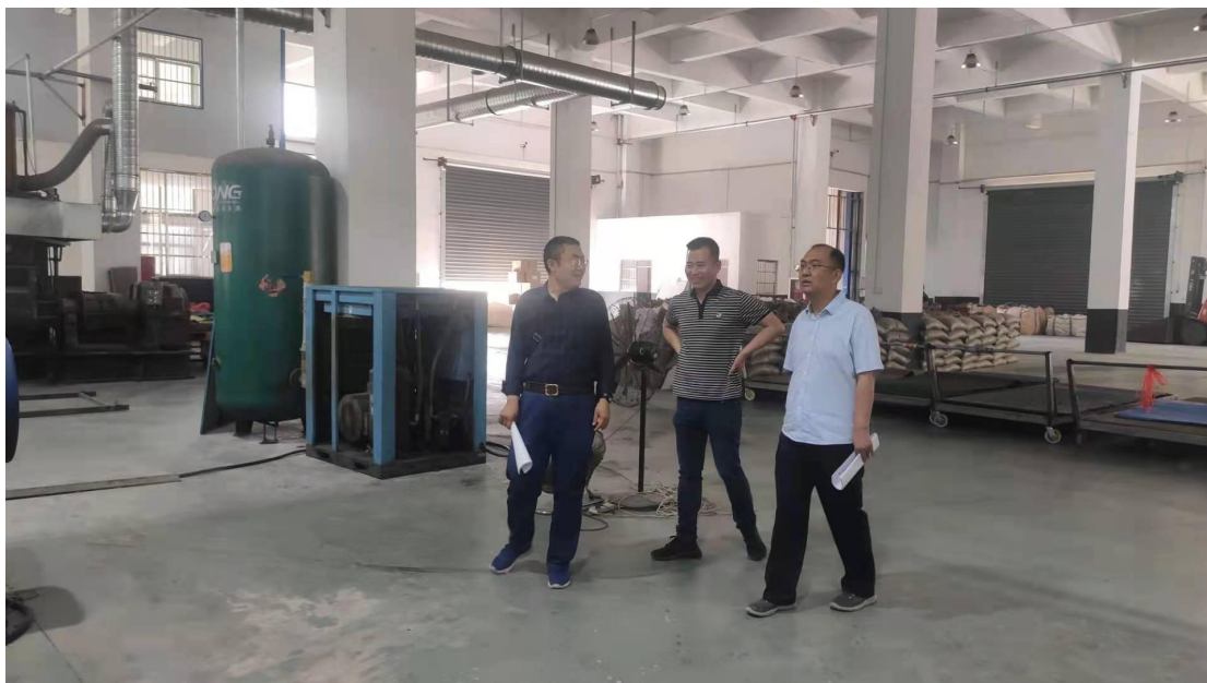
验收工作组踏勘项目现场
