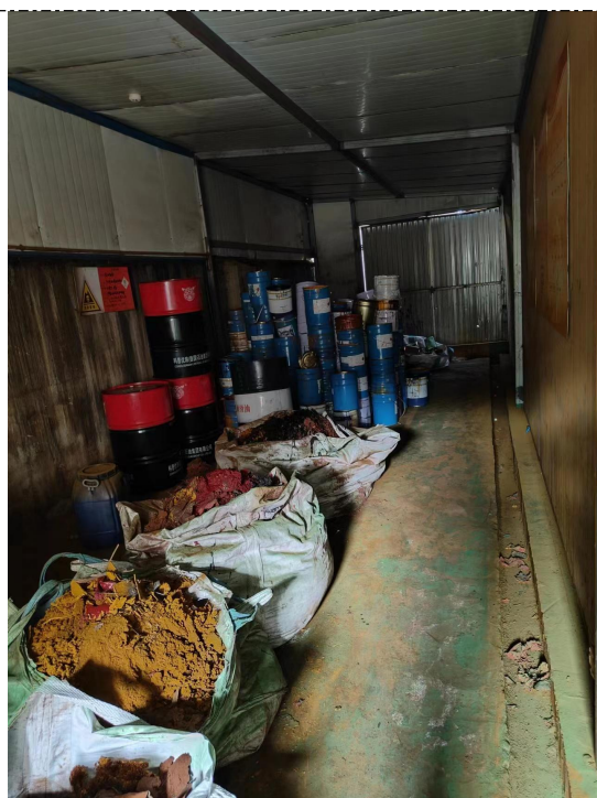
危废库内部分区防渗
