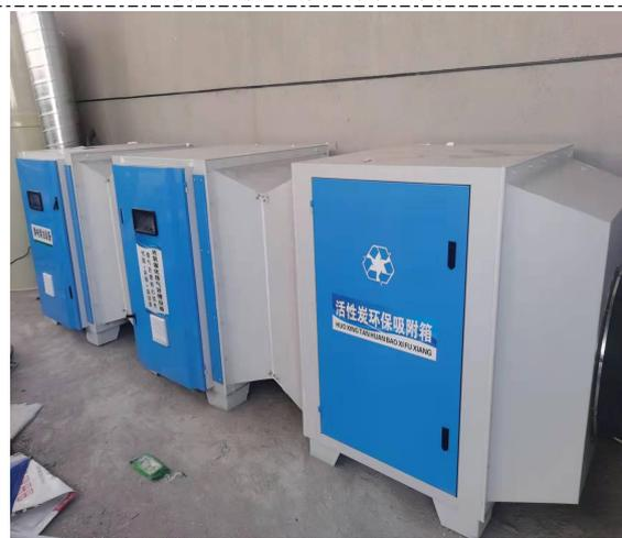
熔融挤出废气处理设备（静电除油+光催化氧化+活性炭吸附）
