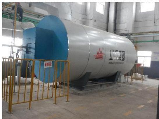
6t/h 燃气导热油锅炉
