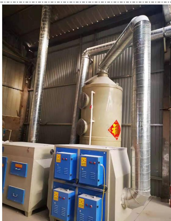
图 4.1-1 挤出工序废气处理设备
