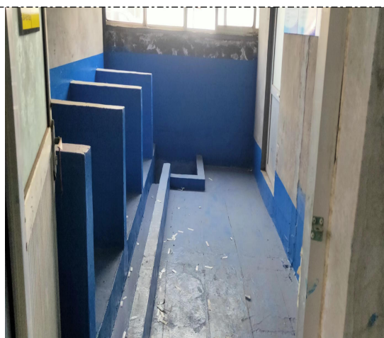
危废库内部分区防渗
