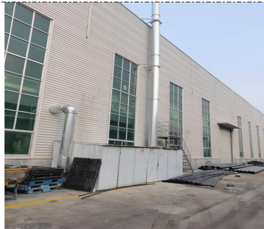
2#生产车间 PE 管挤出废气处理设施（静电除油）
