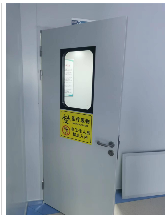
危废库外部危险废物标识牌
