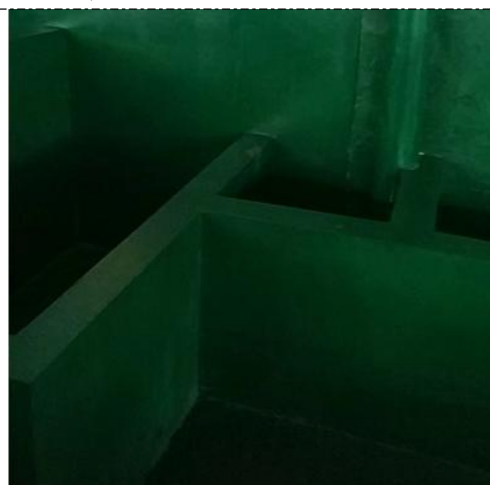
危废库内部分区防渗
