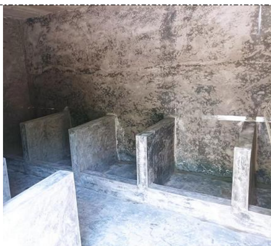
危险废物暂存库内部分区
