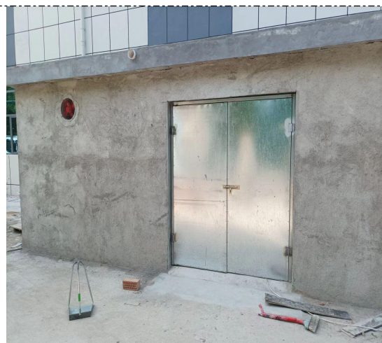
危险废物暂存库外部
