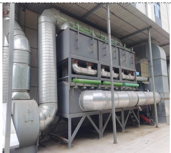
印刷废气环保设施
