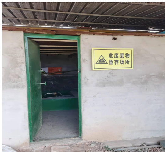
危险废物暂存库外部
