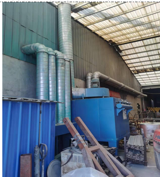
切割烟尘、南侧喷塑粉尘环保设施
