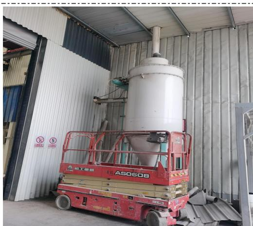
包装废气脉冲布袋除尘器
