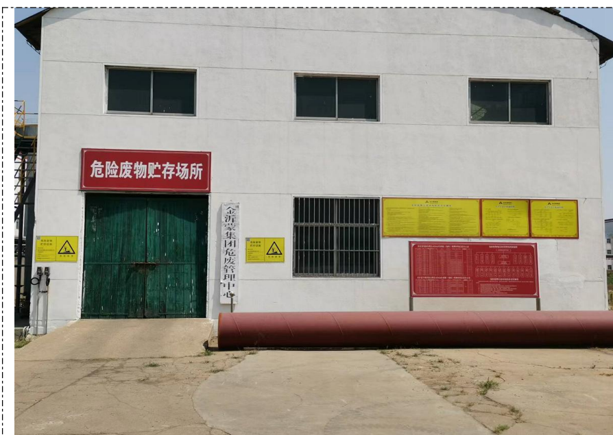
危险废物暂存库外部
