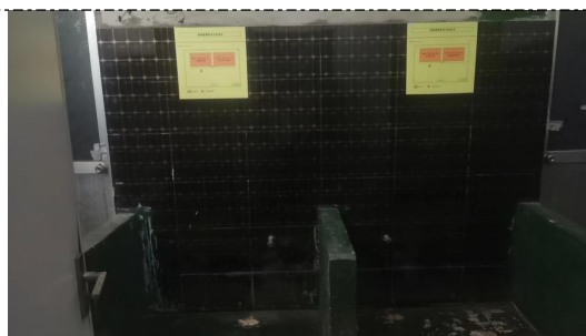
危废库内部分区防渗
