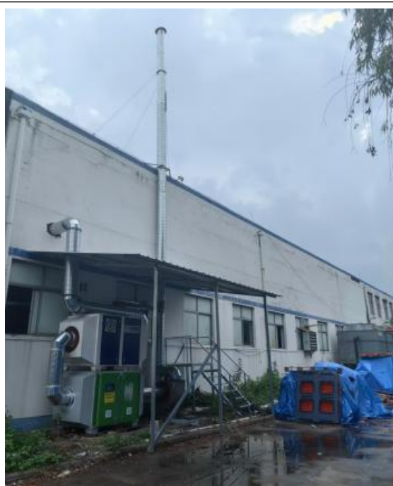
图 4-7 北注塑工序废气排放口采样监测平台及标识
