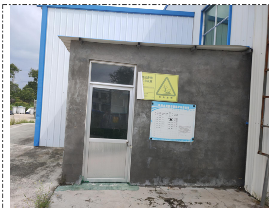
图 4-5 危废暂存间外部
