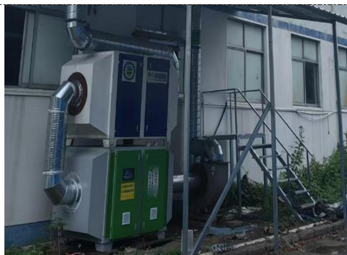
图 4-1 北注塑工序废气处理设施
