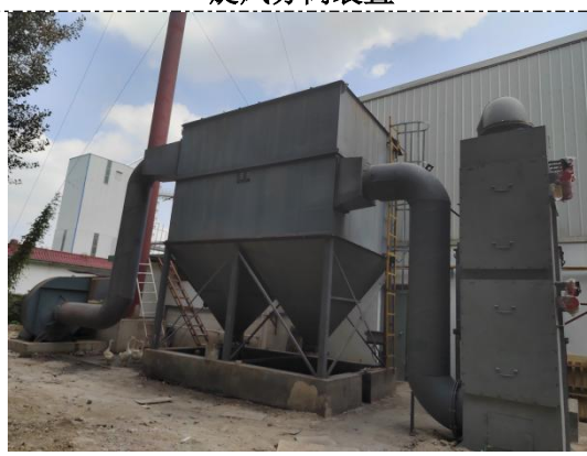
多管除尘+SCR 脱硝+脉冲布袋除尘
