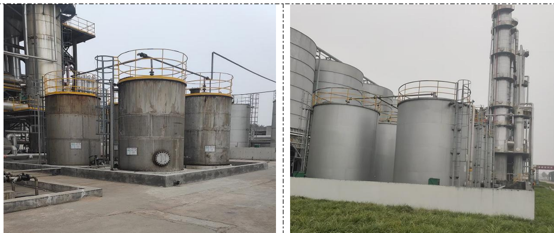
酒精装置区、储罐区围堰
