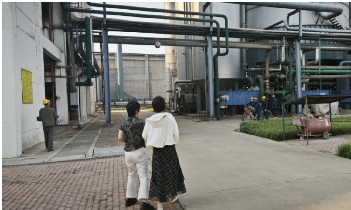
验收工作组踏勘项目现场照片
