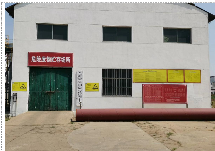
危险废物暂存库外部
