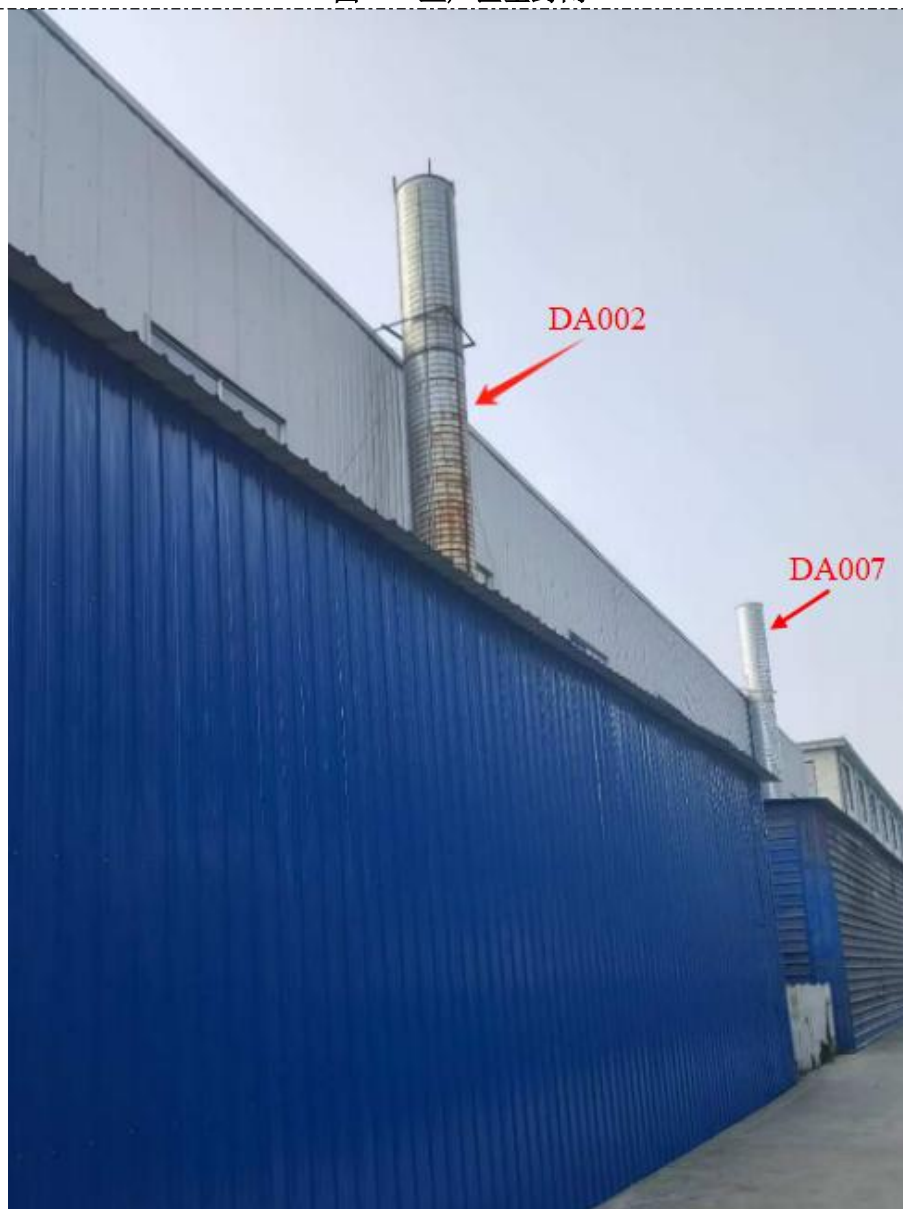
图 4-3 废气排气筒现场照片
