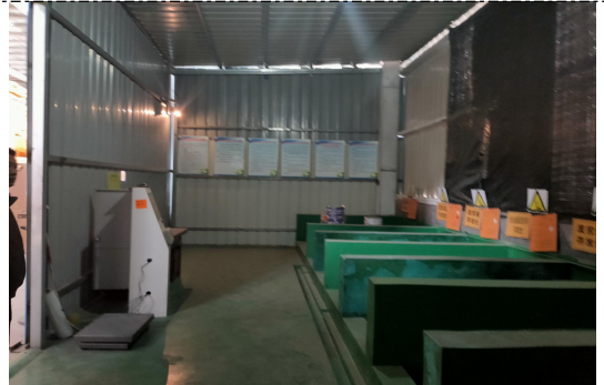
图 4-5 危废暂存间内部
