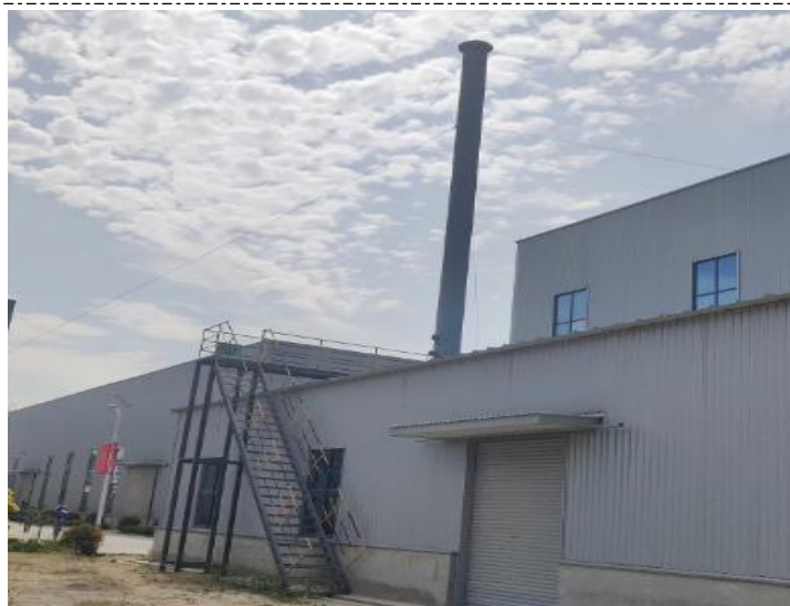
水滑石车间废气排气筒（DA005）
