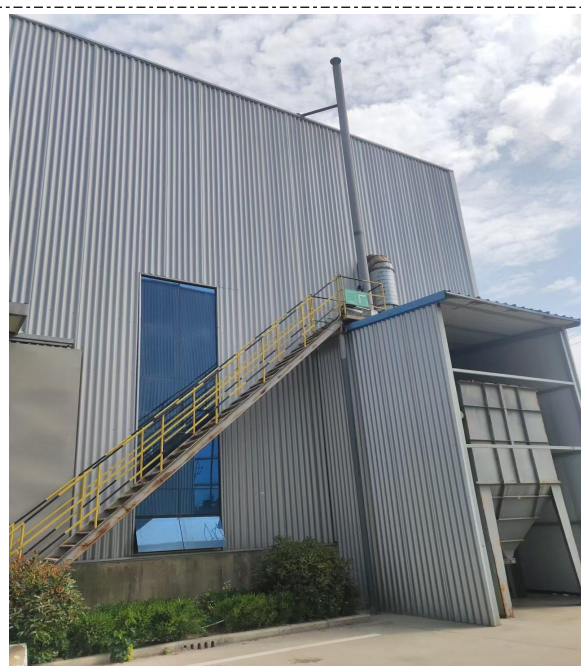
钙锌稳定剂车间废气排放口规范化建设
